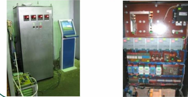
Автоматизированный стенд проверки выпрямитель-инверторного преобразователя электровозов переменного тока
